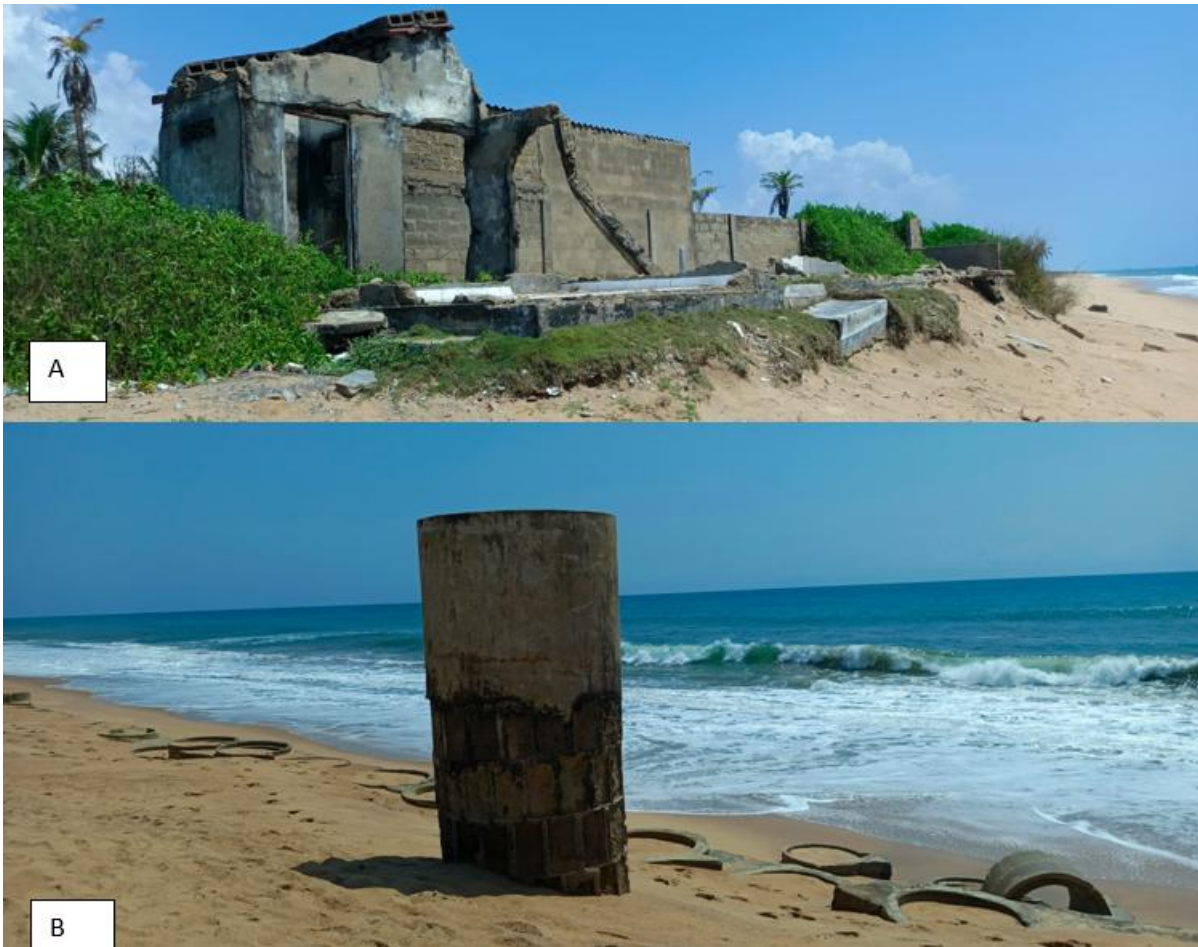
Photo 18 : Anciennes habitations (A) et un puits (B) détruits sous l'effet de l'érosion côtière à Dévikinmé
